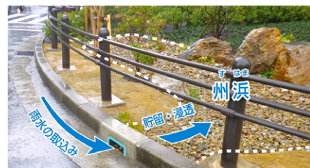
雨庭の実例（雨水を取り込み、石敷きの地面から浸透させる）
