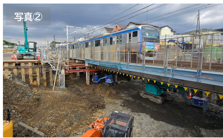
▲ 工事桁によって昼間でも掘削が可能になりました
